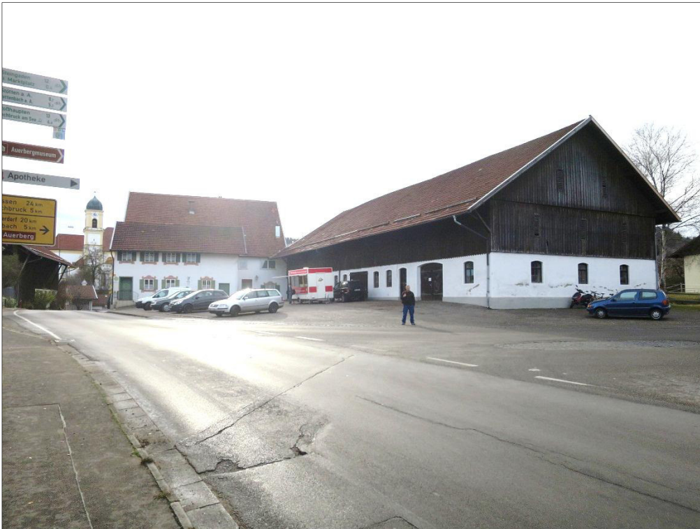
Bild A01: Straßenverlauf im Bereich der Kreuzung Füssener Str./Schongauer Str. und Kaufbeurer Str., im Hintergrund ehemaliger Gasthof "Schnitzer" u. landwirtschaftliches Gebäude (Stand: 11/2016)
